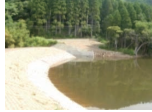
改修後のため池
