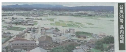
台風24号 (H30.9月) による湛水被害
