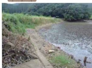
老朽化したため池
