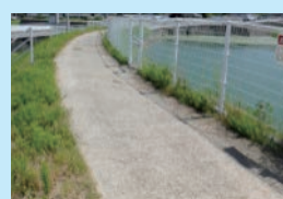
転落防止柵設置
