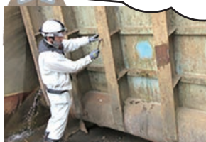
頭首工の扉体の診断状況
