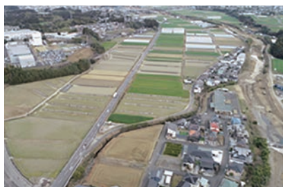
空撮による現地確認
