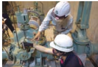
ポンプ施設の点検指導状況
