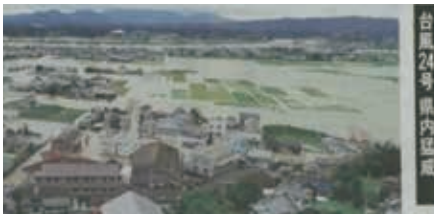
台風24号(H30.9月)による湛水被害
