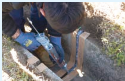
水路の目地補修
