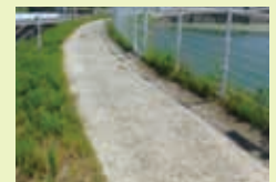
転落防止柵設置
