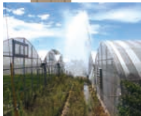
パイプライン(埋設管)の漏水状況
